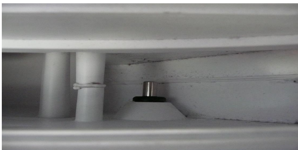
Sonde de sortie filtre (CN6) : 5,7 kΩ à 20°C
